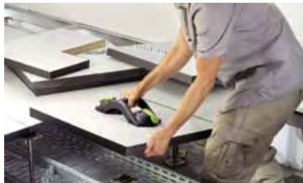
Beim Verlegen von Büroböden und Laminatpaneelen ist der Doppelsaugheber sehr hilfreich.
