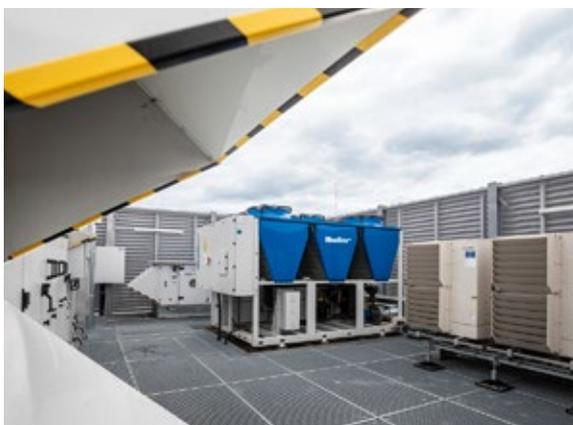
↑ Une pompe à chaleur et un système de refroidissement assurent le chauffage et le rafraîchissement dans le bâtiment.
